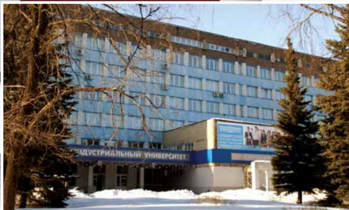
Горно-технологический корпус СибГИУ
