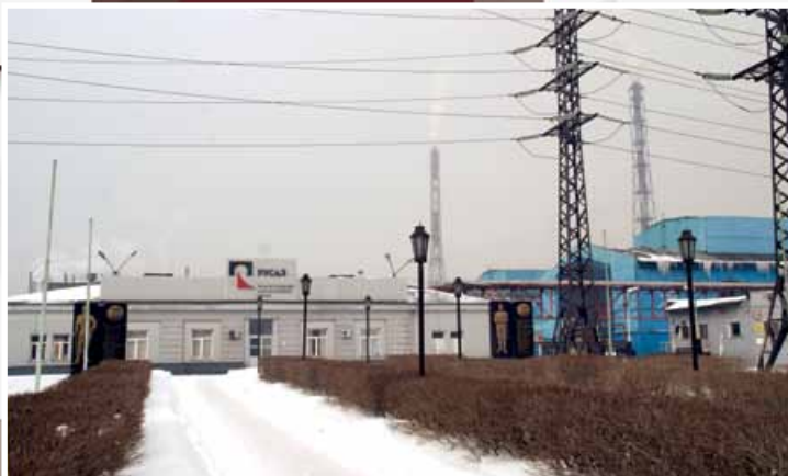
Новокузнецкий алюминиевый завод
