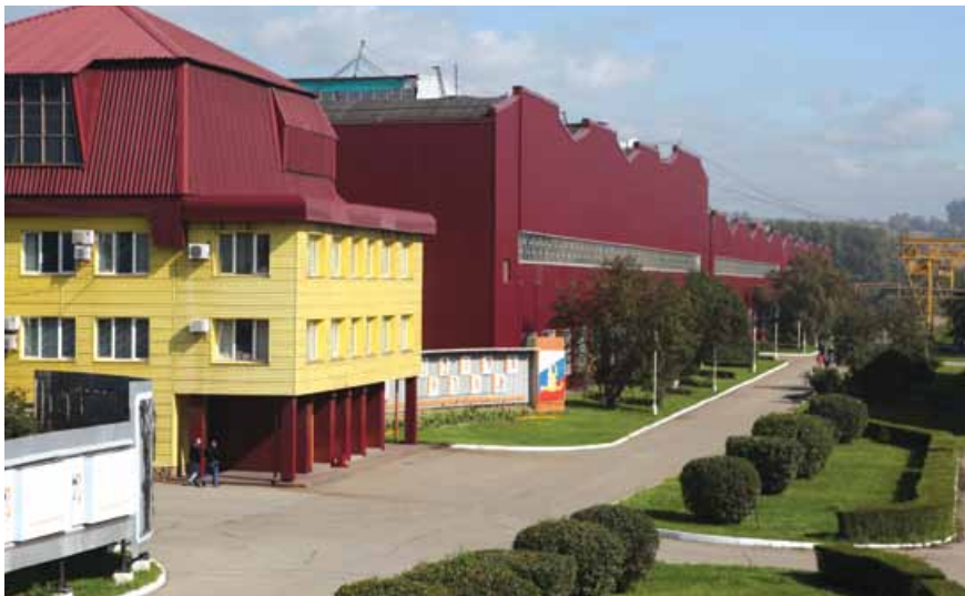
Заводоуправление и один из цехов Новокузнецкого завода резервуарных металлоконструкций им. Н.Е. Крюкова
