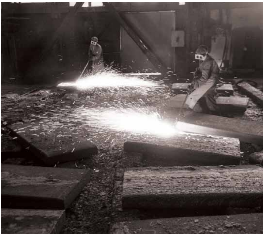
Участок зачистки слэбов Кузнецкого металлургического комбината
