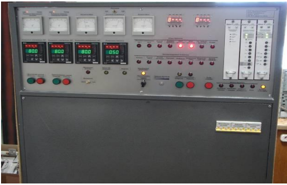
Система управления и устройство плавного пуска синхронных электродвигателей компрессорных установок
