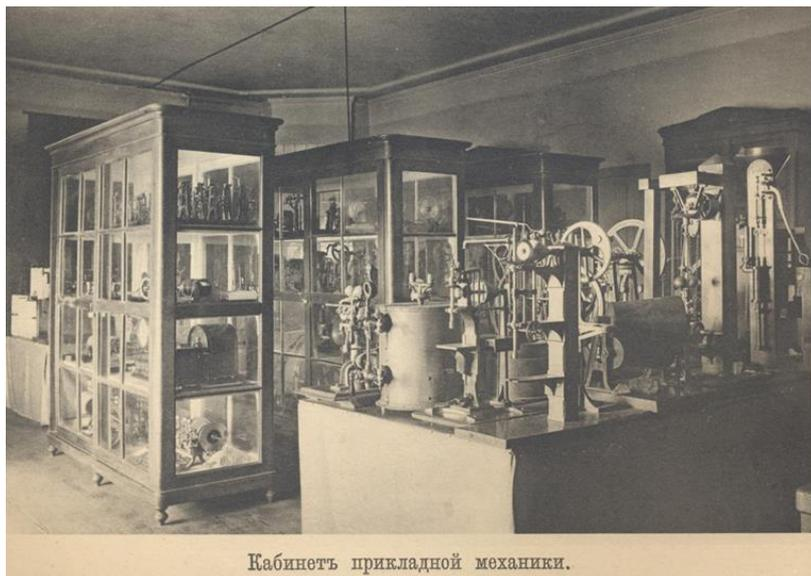
*Рис. 1. Фото коллекции кинематических моделей для преподавания курса «Прикладной механики» в ИМТУ, начало XX века*
