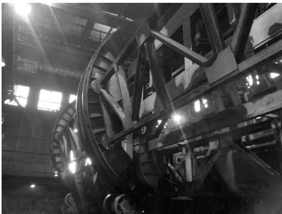
рис. 1 Опрокидывательная установка вагонов
