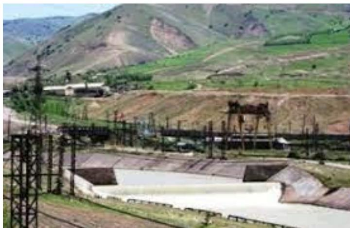
Рис. 4. Обводной канал с водобойными гасителями энергии
