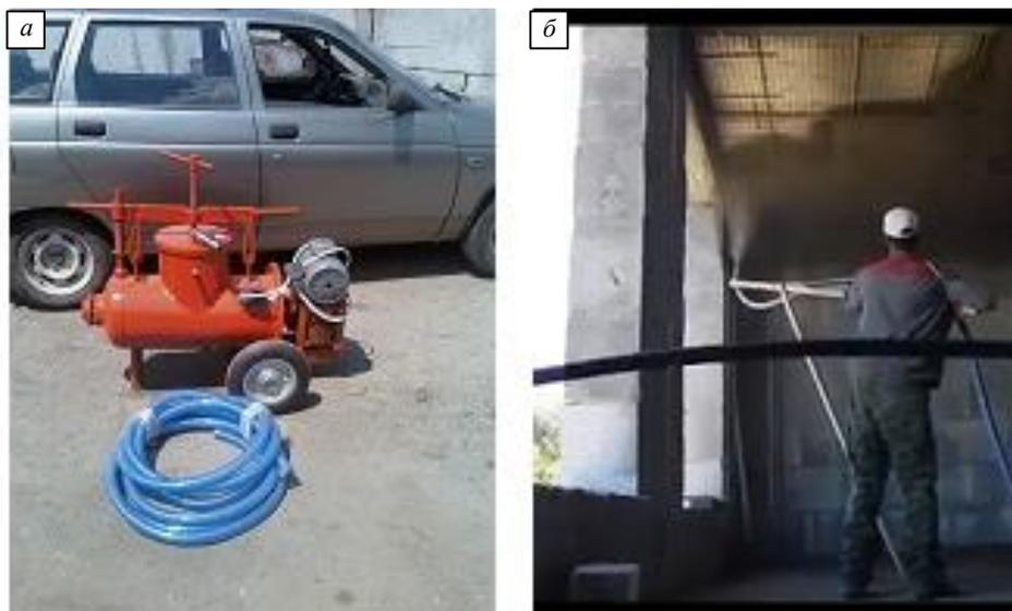
Рис. 1. Мобильное оборудование и технология нанесения набрызгбетона полусухим методом
