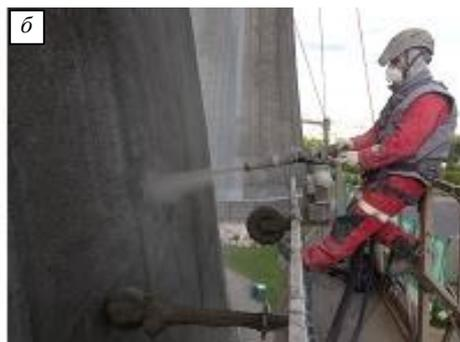
Рис. 3. Работа изделия *Termiton*<sup>®</sup> X5 с торкрет установкой *Aliva*<sup>®</sup>-257 в шахте (а) и на высоте (б)
