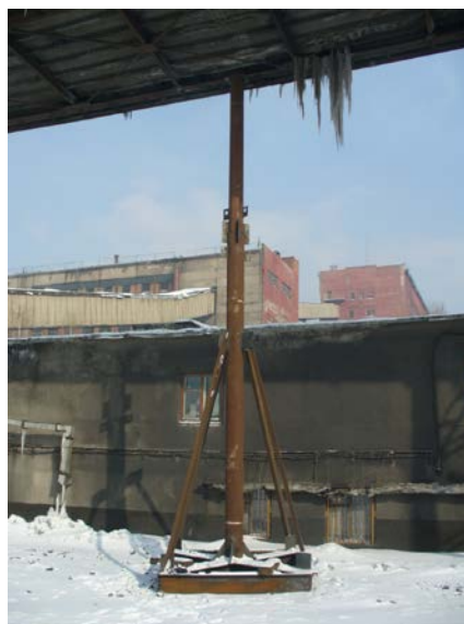
Рис. 2. Временная дополнительная стойка
