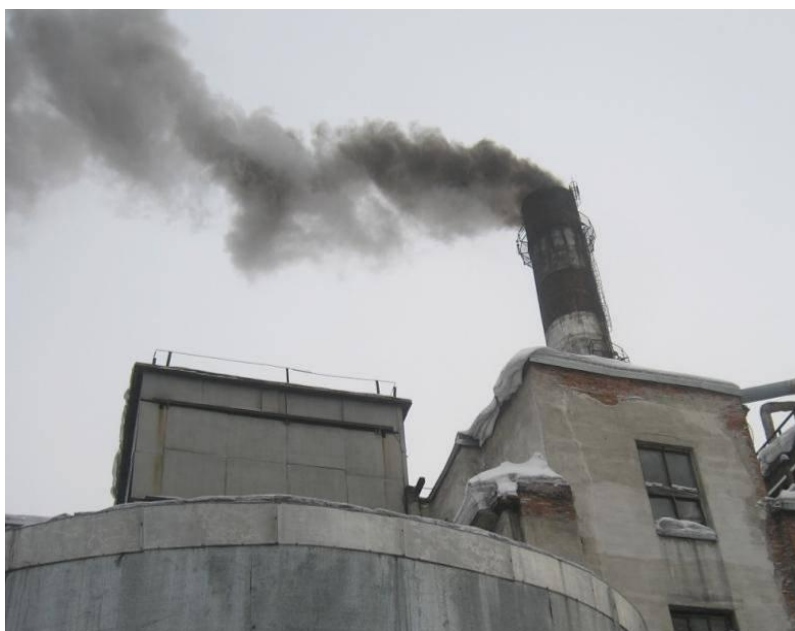
Рисунок 2 – Выбросы из дымовой трубы
