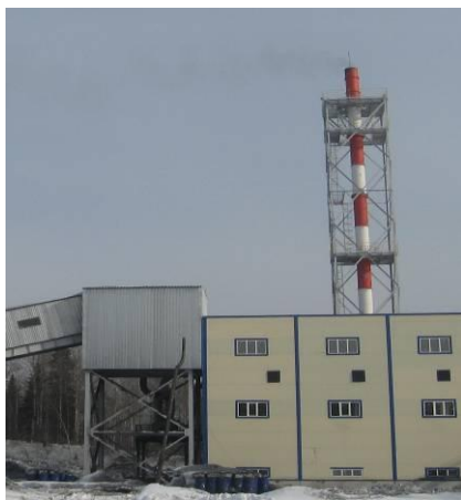
Рисунок 7 – Котельная шахты Южная
