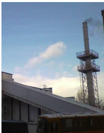
Рисунок 6 – Котельная Шахты Большевик
