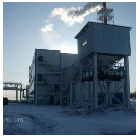
Рисунок 8 – Котельная шахты Красногорская
