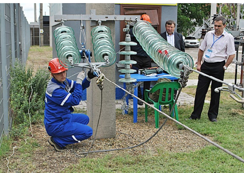
Демозкамен в Центре оценки электроэнергетических квалификаций «Энергия» (Республика Адыгея)
