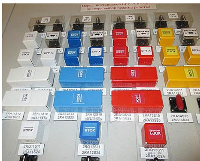
Методы минимизации ошибок при управлении оборудованием: пломбирование ключей управления, предупреждающие таблички, бирки. Калининская АЭС
