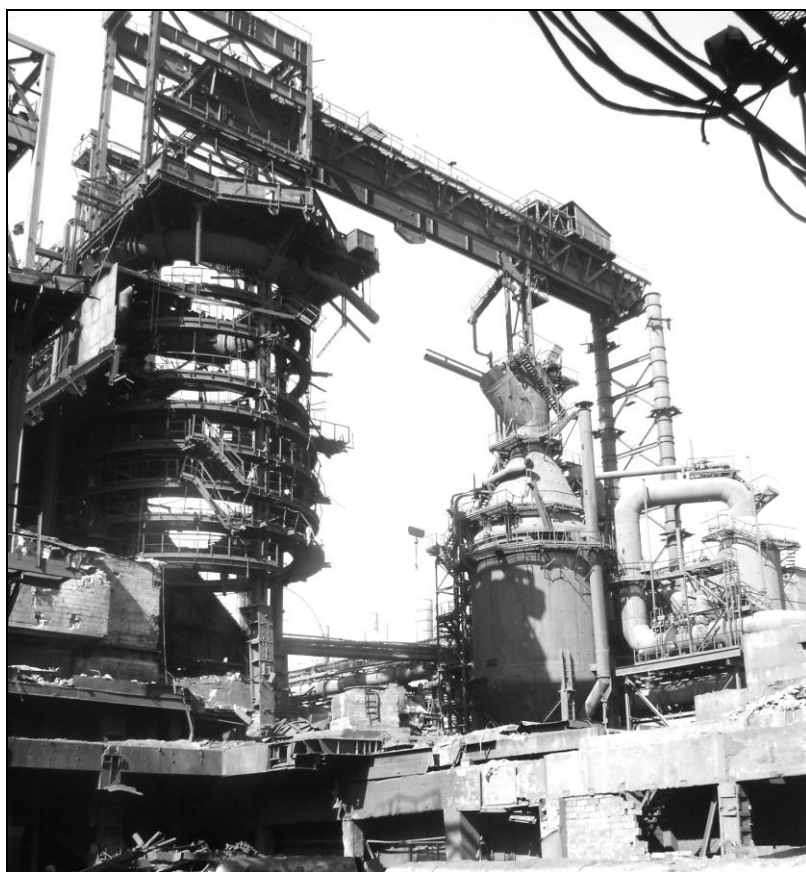
Рисунок 1 – Демонтаж доменной печи Кузнецкого металлургического комбината, фото
