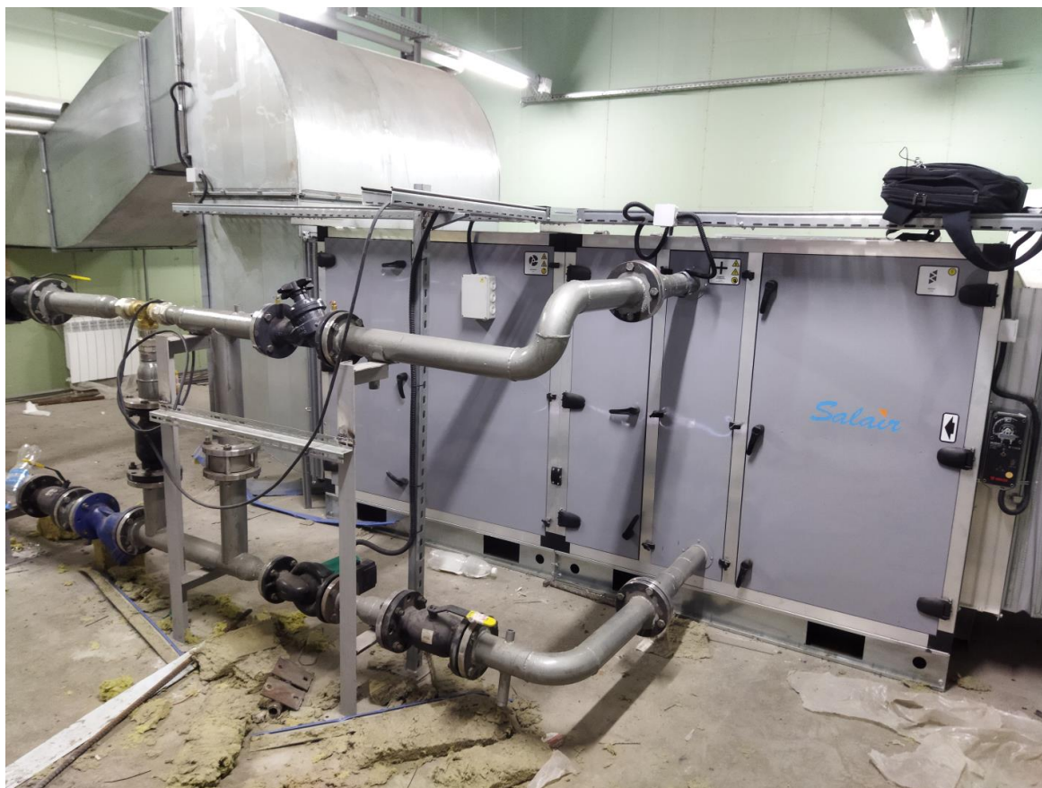
Рисунок 1 – Внешний вид приточной вент системы
