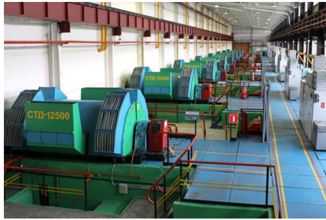
Рисунок 1 – Общий вид КС с электроприводами СТД-12500 для ГПА
