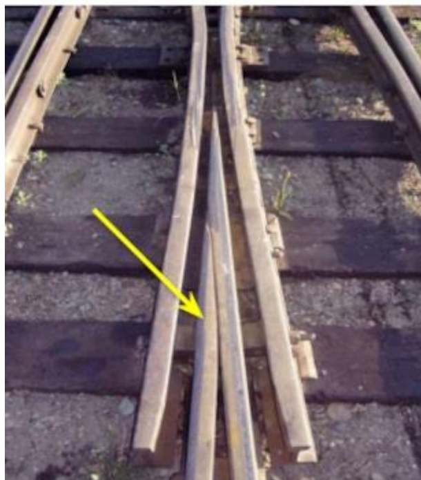
Рисунок 1 – Износ сердечника стрелочного перевода
