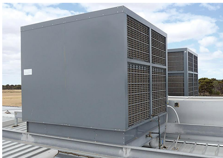
Рисунок 4 - Система с двухступенчатым испарительным охлаждением
