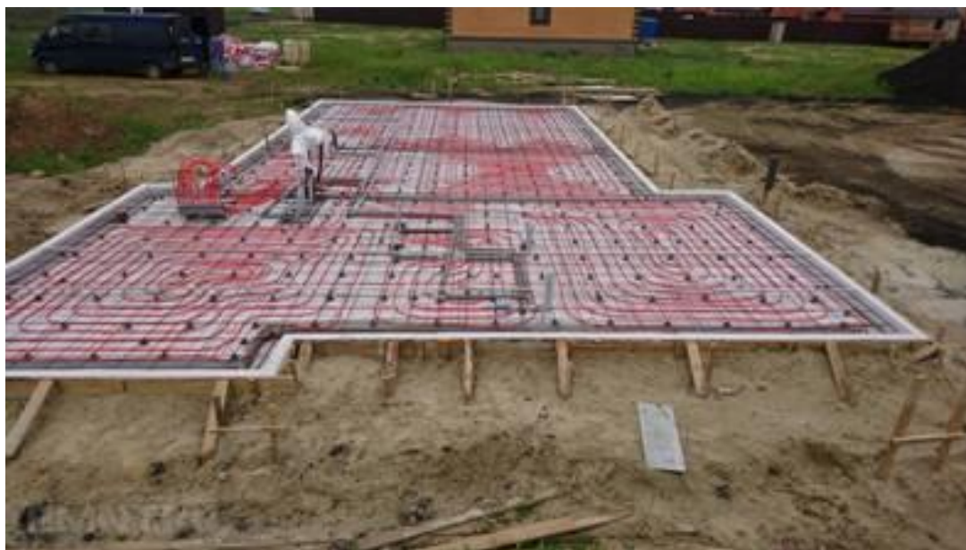
Рисунок 1 – Фундаментная плита с подогревом
