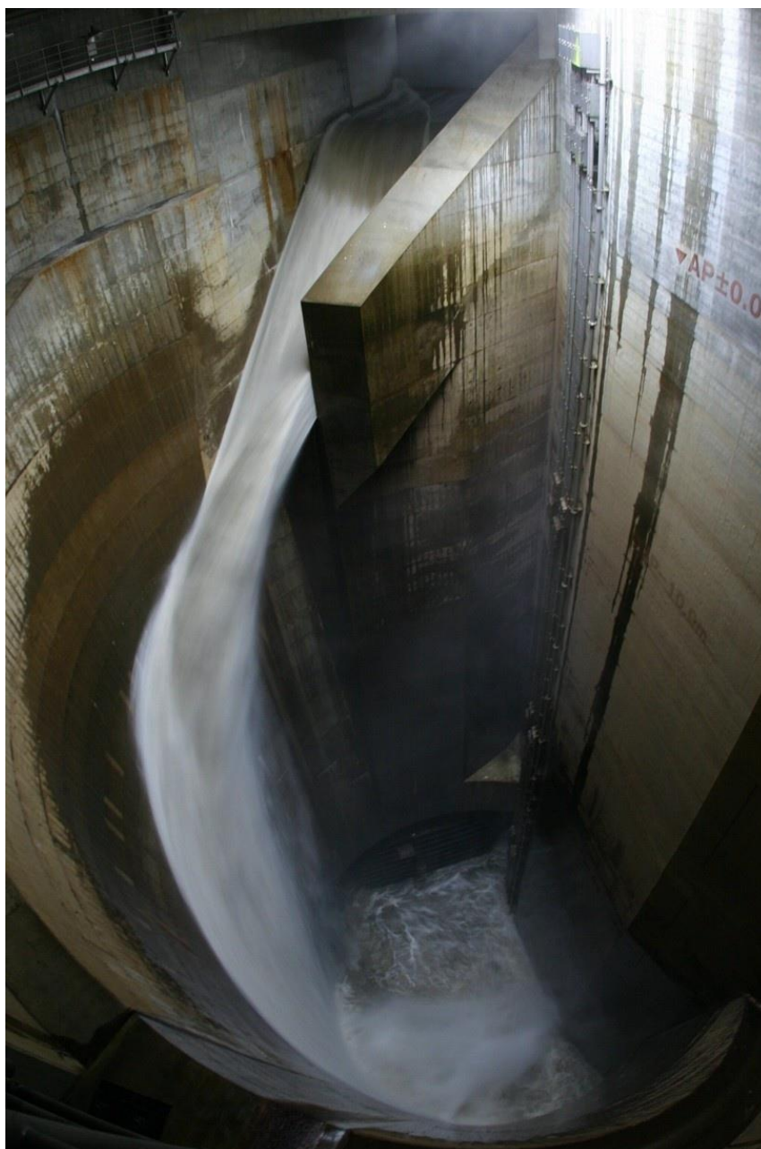
Рисунок 2 – Заполнение коллектора во время паводка
