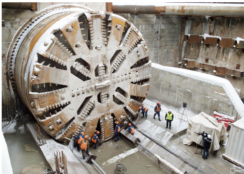
Рисунок 5 – Щитовая проходческая машина для строительства тоннеля
