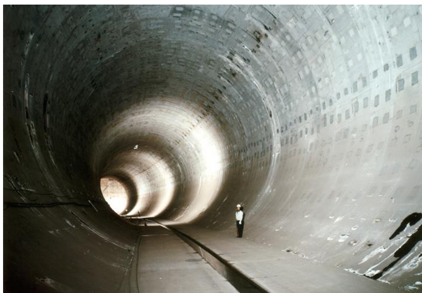
Рисунок 4 – Тоннель диаметром 10,6 метров и общей протяженностью 6,3 км.
