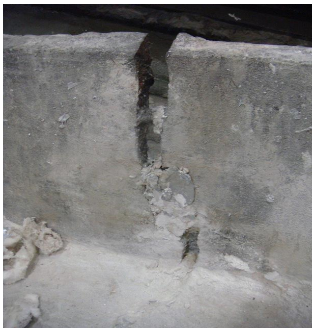
Рисунок 2 - Трещина в изделии из-за высокого содержания серы
