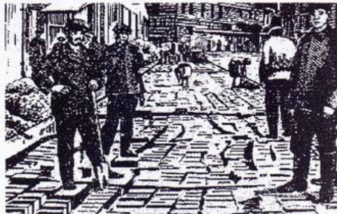
Рисунок 5 – Работы по устройству клинкерной мостовой на Пушечной улице Москвы, фото 1932 г.
