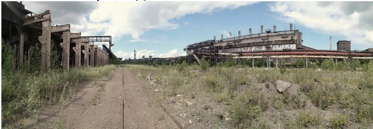
Рисунок 1 – Фотофиксация существующей ситуации на территории Новокузнецкого металлургического комбината. Фото автора 2022 г.
