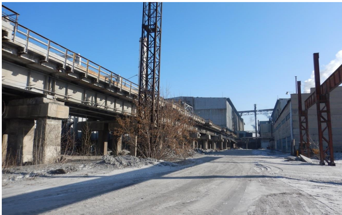
Рисунок 1 – Вид железнодорожной эстакады
