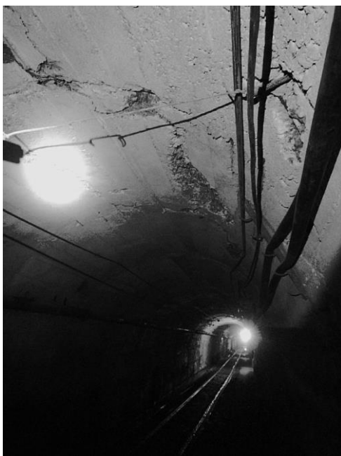
Рисунок 1 – Нарушение железобетонной крепи после микроудара
