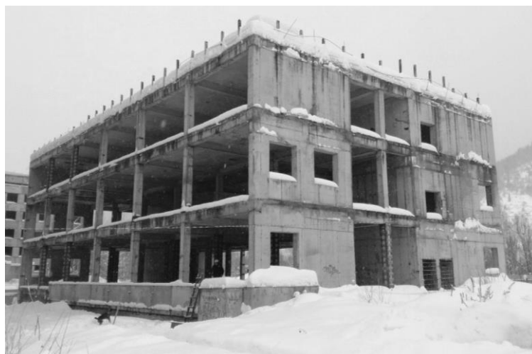
Рисунок 2 – Общий вид Блока Б в осях А-Е
