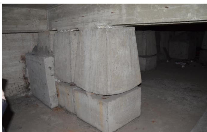
Рисунок 2 – Сейсмоопоры Черепинского (вид 2)
