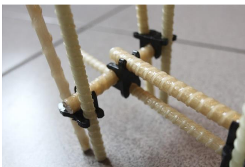
Рисунок 2 – Каркас из композитной арматуры
