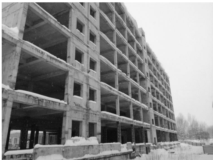
Рисунок 1 – Общий вид Блока А в осях 18-1
