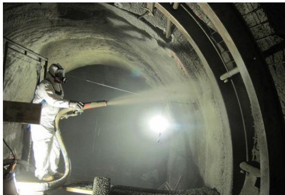
Рисунок 1 – Нанесение набрызг-бетона/ торкрест-бетона
