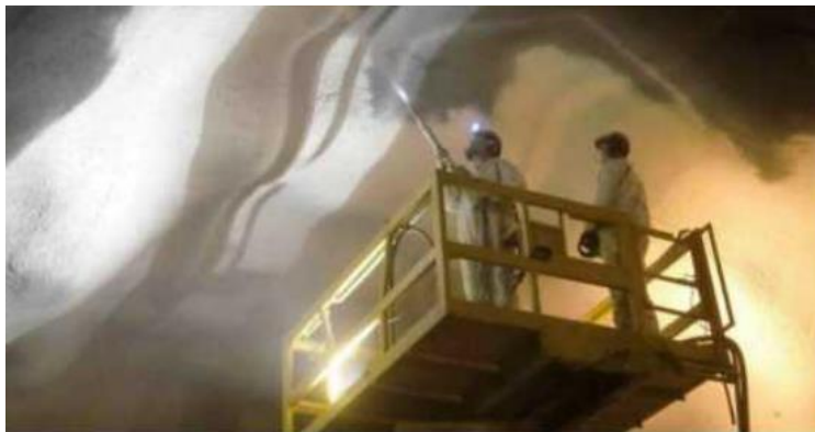
Рисунок 1 – Нанесение полимерного покрытия
