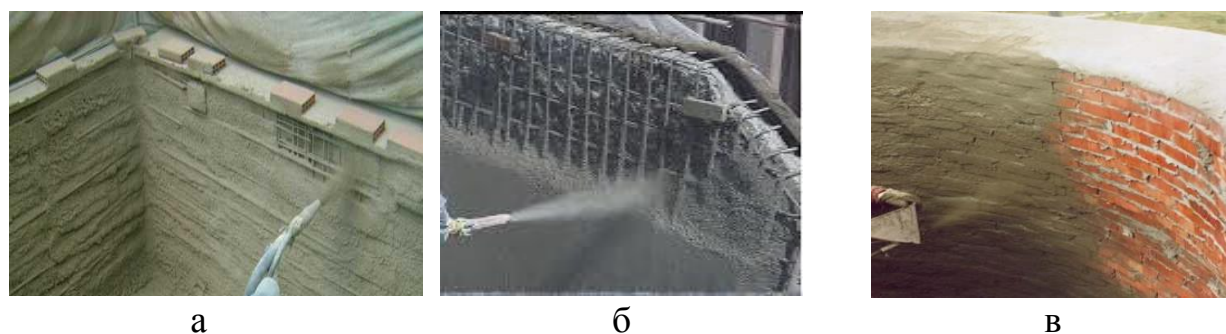
а – стена печи; б – фундамент печи; в – дымовая труба
