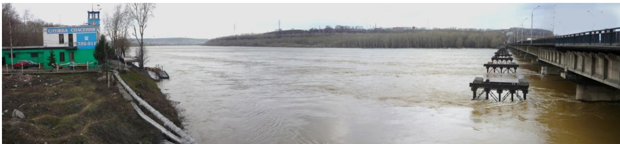
Рис. 4. Мост через реку Томь между Центральным и Кузнецким районами
