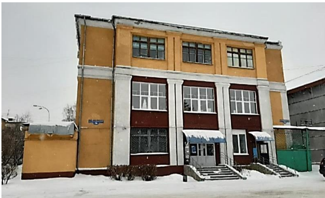
Рис. 2. Здание бывшей фабрики «Березка» (фото автора 2019 г.)
