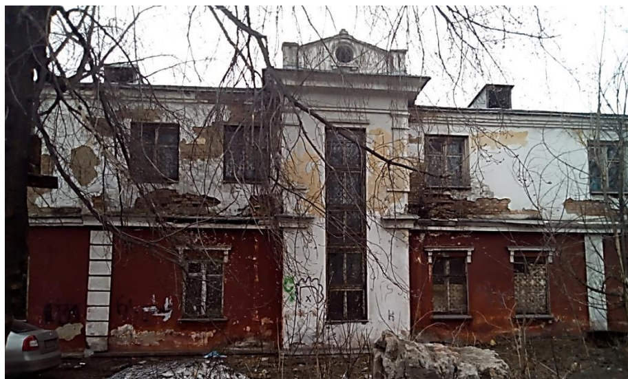
Рис. 3. Дворовый фасад здания (фото автора 2020 г.)
