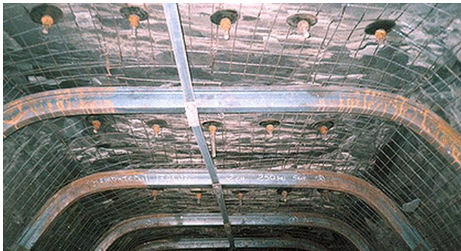
Рисунок 2 – Комбинированная металлорамная крепь с анкерами глубокого заложения
