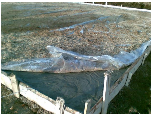
Рисунок 1 - Устройство бетонной смеси
