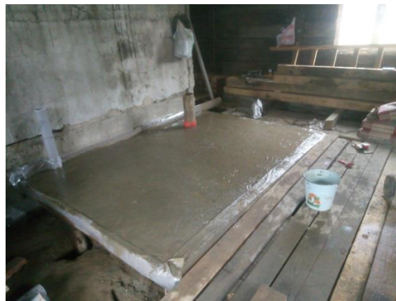
Рисунок 4 – Монолитная плита на этапе изготовления
