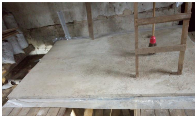
Рисунок 5 – Плита после снятия опалубки
