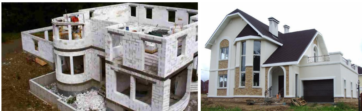
Рисунок 4 – Примеры строительства из газоблоков и пеноблоков
