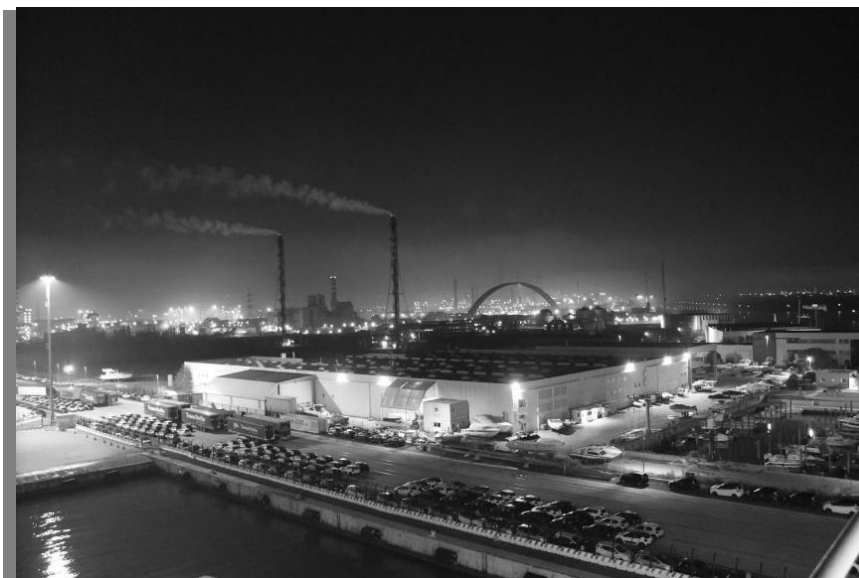
Рисунок 1 – Общий вид Fusina hydrogen power station
