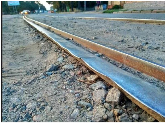
Рисунок 1 – Дефекты поверхности катания трамвайных рельсов
