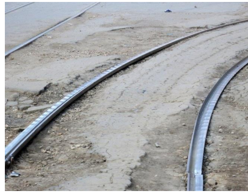
Рисунок 1 – Дефекты поверхности катания трамвайных рельсов
