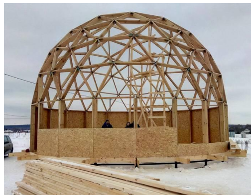
Рисунок 1 – Каркасная купольная конструкция на свайном фундаменте
