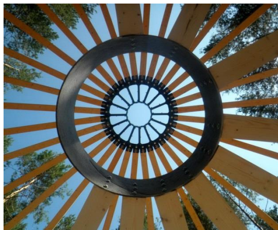
Рисунок 3 – Крепление каркаса купольного дома в верхней точке
