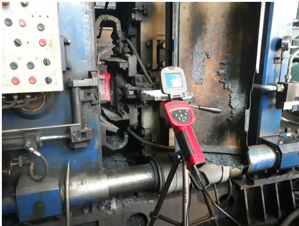
Рисунок 1. Оборудование для измерения температуры сварного соединения рельсов
