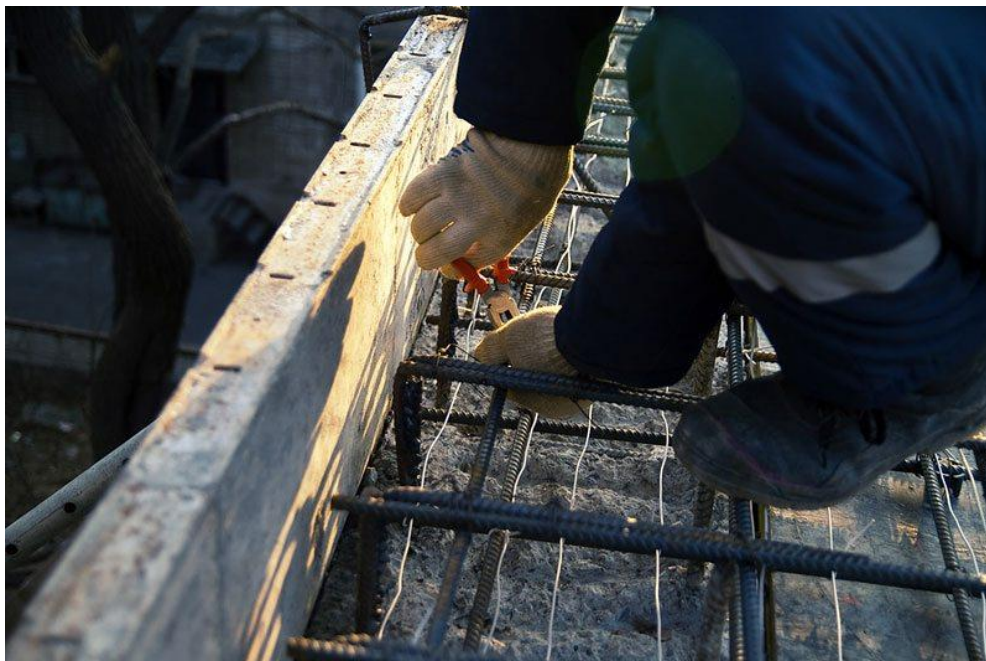
Рисунок 3 – Расположение нагревательными проводами в арматурном каркасе
