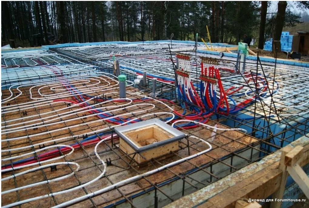
Рисунок 4 – Укладка греющего провода ПНСВ в арматурном каркасе
