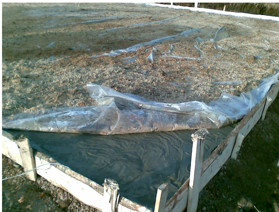
Рисунок 1 – Устройство и прогрев бетонной смеси на промышленных стройках
