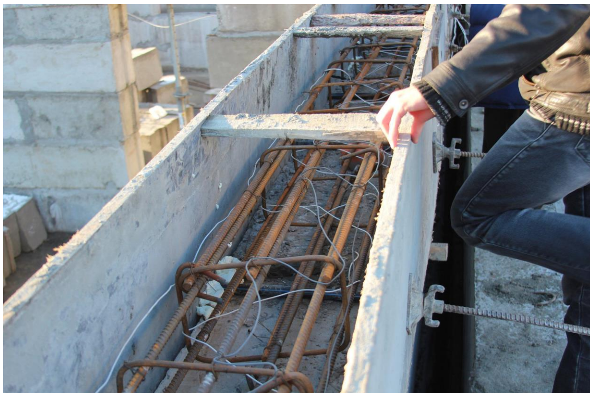
Рисунок 2 – Пример утепления опалубки пенопластом
