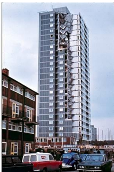
Рисунок 1 - Разрушение дома Ронан Пойнт (Ronan Point)
