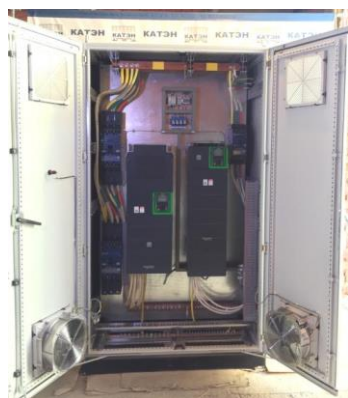
Рисунок 2 – Шкаф силового оборудования (двухсторонний)
