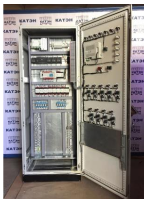
Рисунок 3 – Компоновка и лицевая панель шкафа управления
