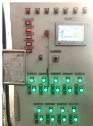
Рисунок 3 – Компоновка и лицевая панель шкафа управления
