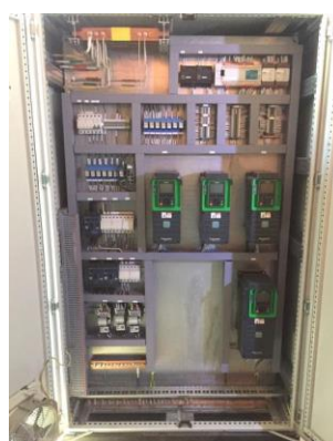
Рисунок 2 – Шкаф силового оборудования (двухсторонний)
