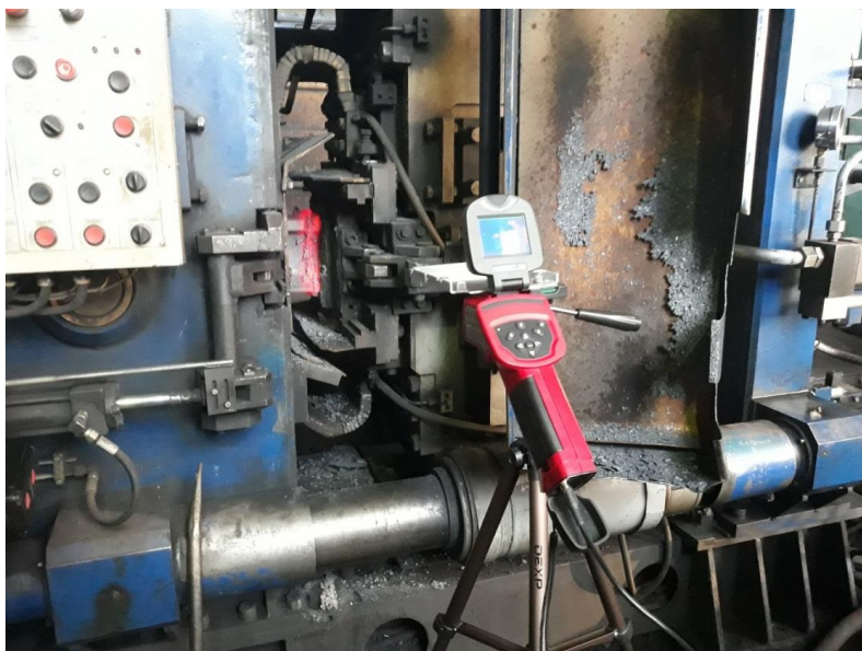
Рисунок 2 – Оборудование для измерения температуры сварного соединения рельсов
