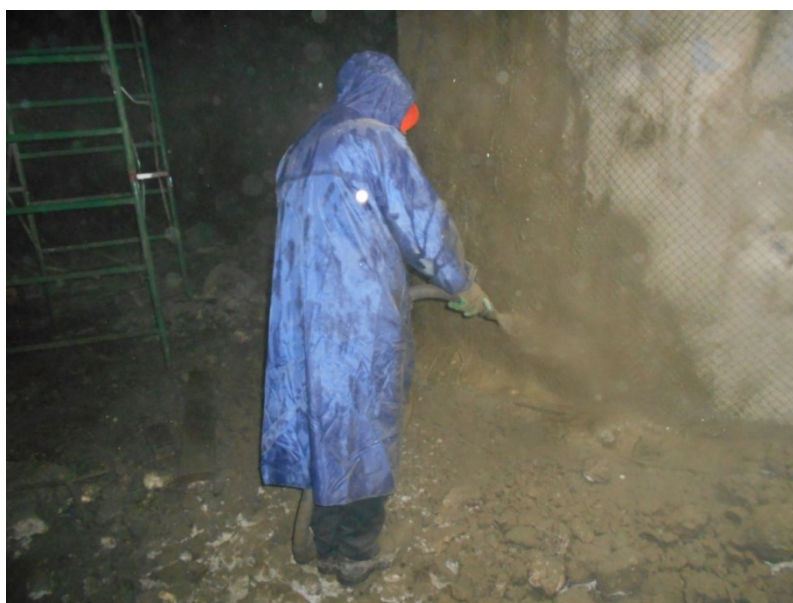
Рис. 5. Торкретирование кислотоупорным составом
