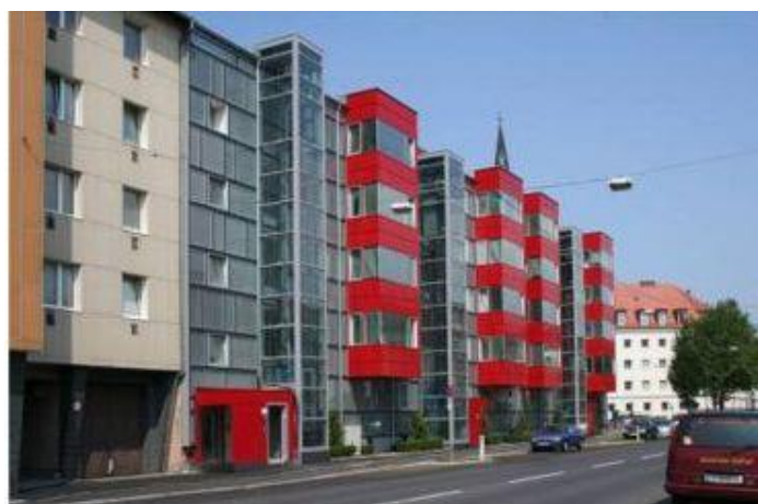
Рисунок 2 – Реконструкция жилого комплекса на ул. Макартштрассе в г. Линце (Австрия)
