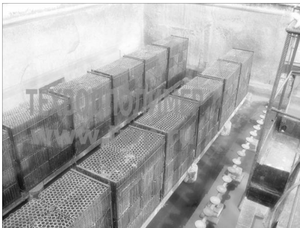
Рисунок 2 - Расположение биоблоков в аэротенках
