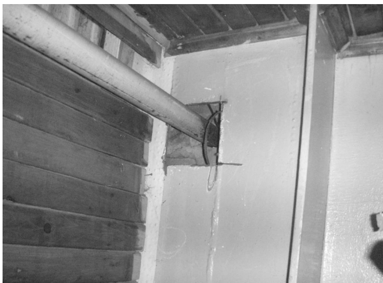
Рисунок 1 - Вырез в стойке рамы
