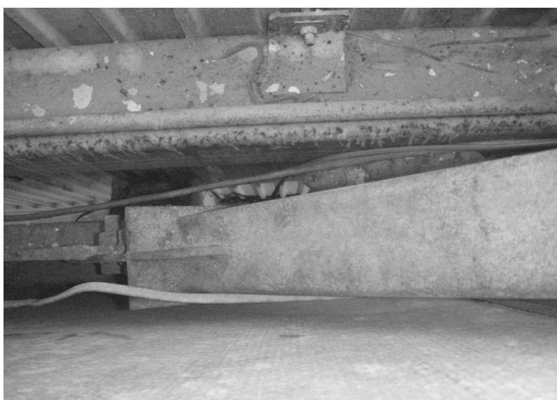
Рисунок 2 - Коррозия ригеля
