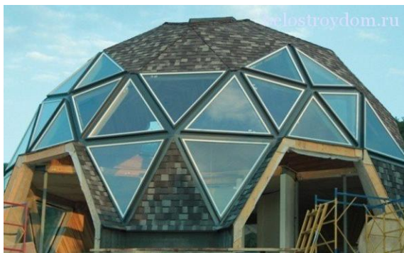
Рис. 4. Пример размещения окон при строительстве купольного здания
