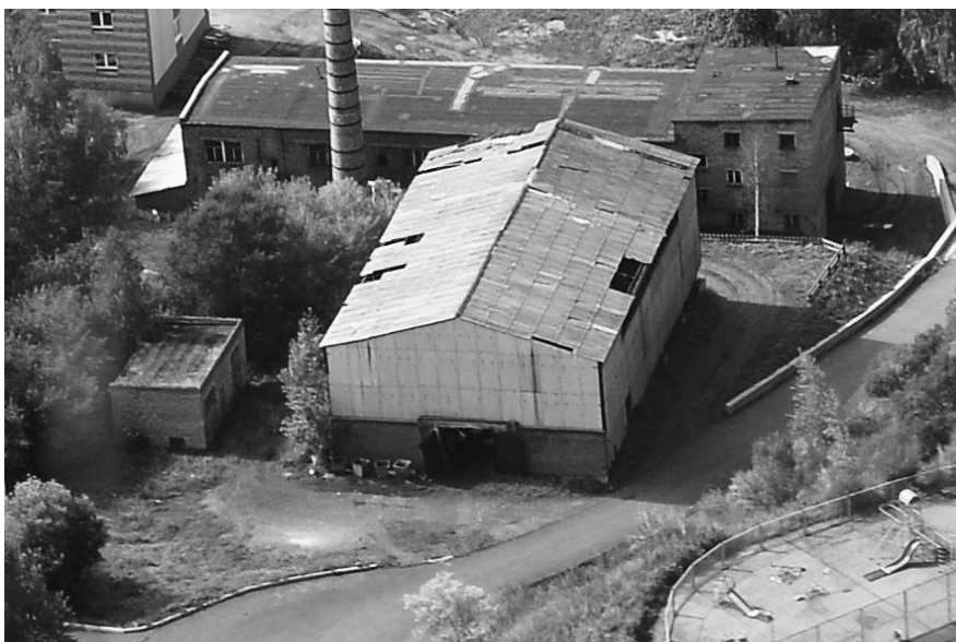
Рисунок 1 – Существующее здание угольного склада
