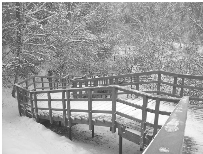
Рисунок 2 - Фрагмент лестницы на винтовых сваях
