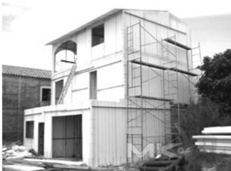
Рисунок 1 - Здание из многослойных панелей 3D
