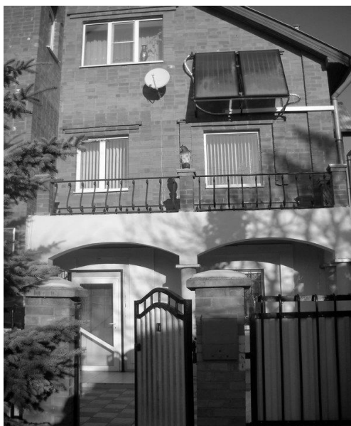
Рисунок 3- Жилой дом в Горно-Алтайске с солнечной установкой
