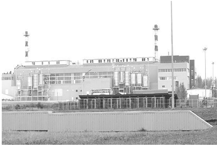
Рисунок 2 - Завод по сжиганию осадков сточных вод
