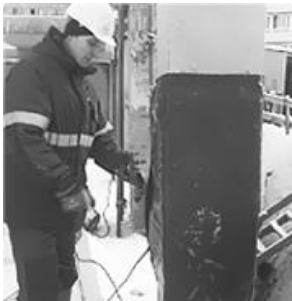
Рисунок 2 - Обогрев бетона в стыке колонн с использованием термоматов
