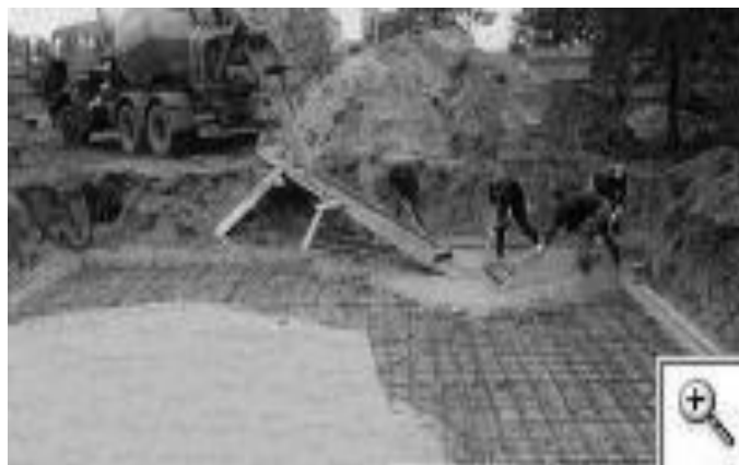
Рисунок 3 – Установка фундаментной плиты
