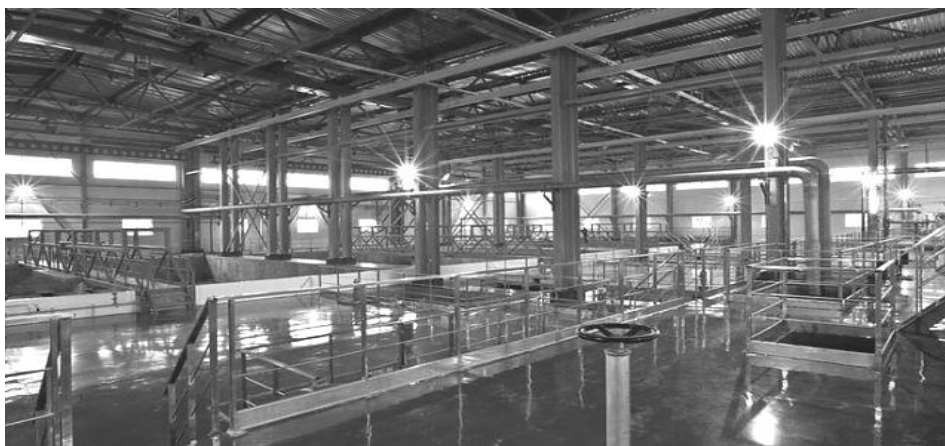
Рисунок 1 - Новый блок водоподготовки
