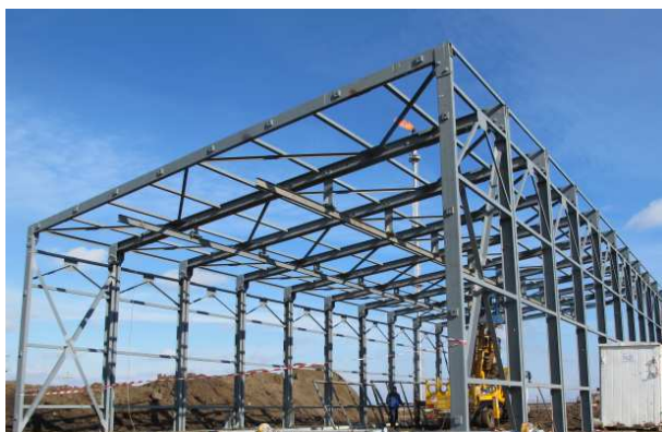
Рисунок 1 – Металлокаркас быстровозводимого здания
