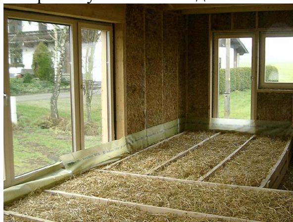
Рисунок 1 – Внутренний вид строящегося дома.
