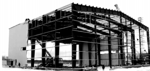
Каркас одноэтажного промышленного здания из легких металлоконструкций
