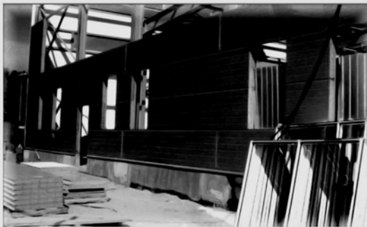
Трехслойные панели типа «Сэндвич» с утеплителем из минеральной ваты или пенополистирола
