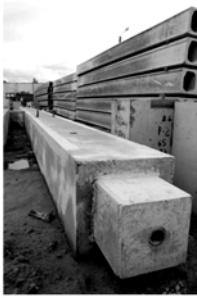
Железобетонная колонна прямоугольного сечения
