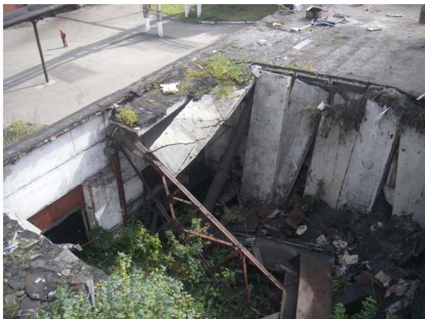
Рисунок 3 – Покрытие здания пристройки
