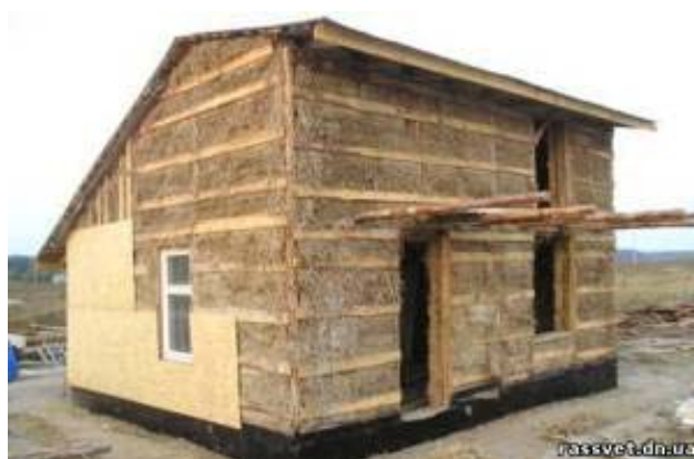
Рисунок 2 – Внешний вид строящегося дома.
