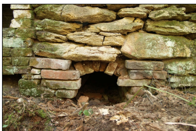
Рисунок 9 – Топка Полдневной печи (слева видны воздушные каналы для прогрева воздуха)
