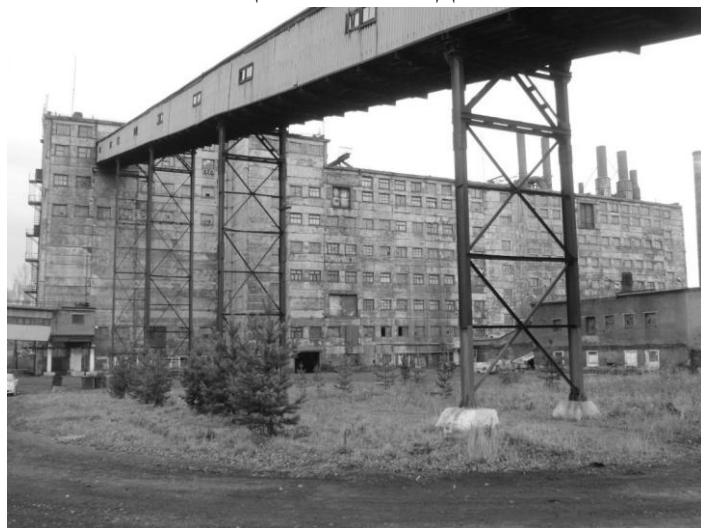
Рисунок 1 – Общий вид здания со стороны оси А
