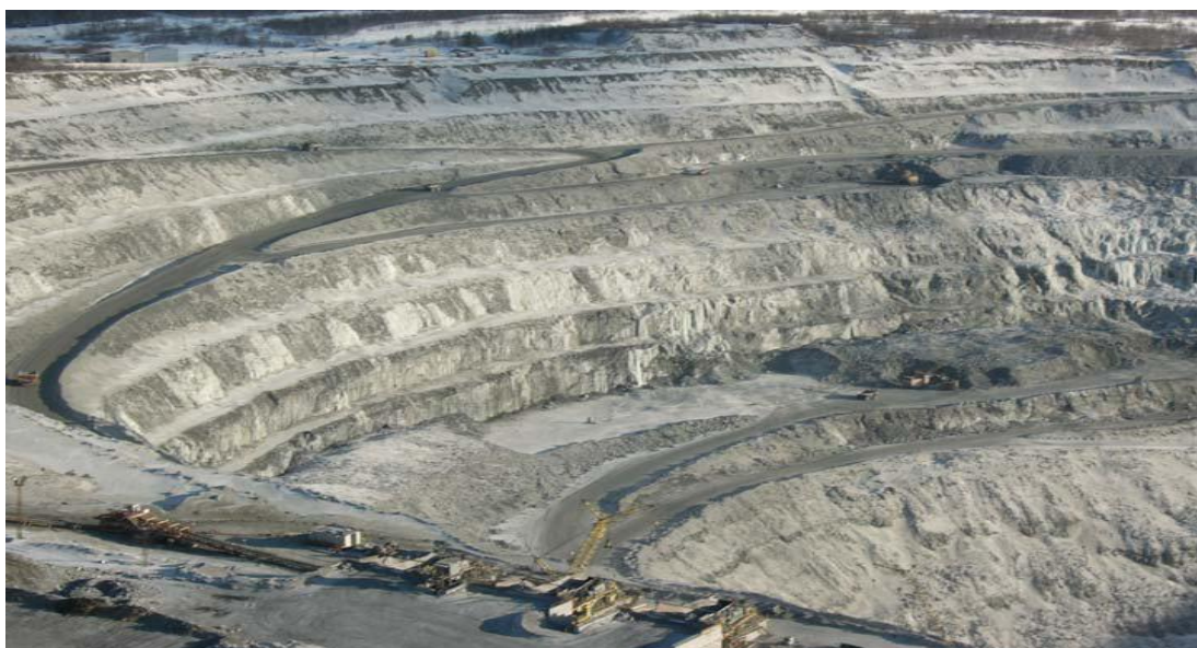
Рисунок 2 – Участок борта рудника «Железный» ОАО «Ковдорский ГОК» с применением вертикальных откосов уступов высотой 24 метра
