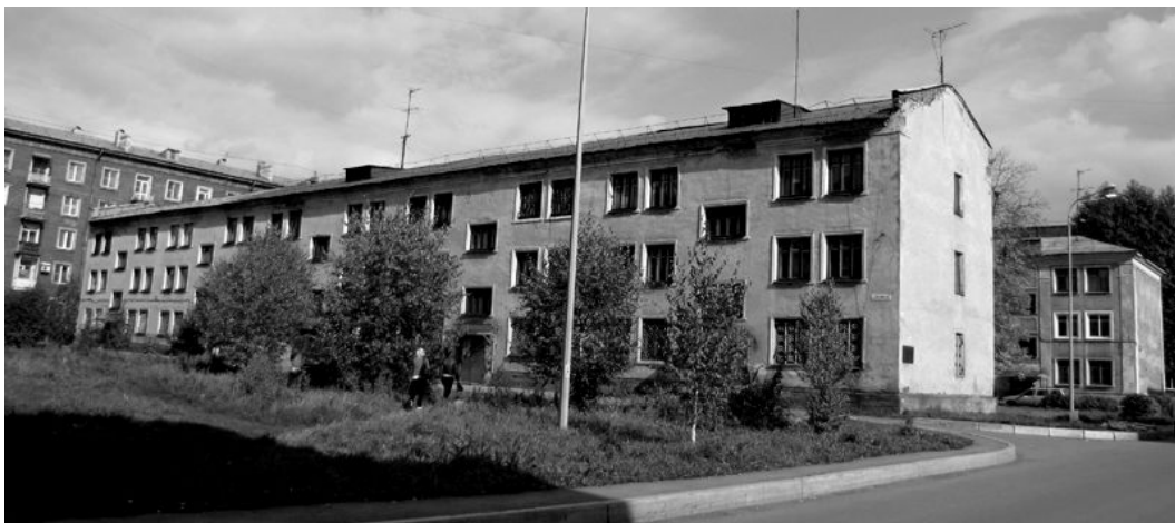
Рисунок 2 – Здание по ул. Хитарова
