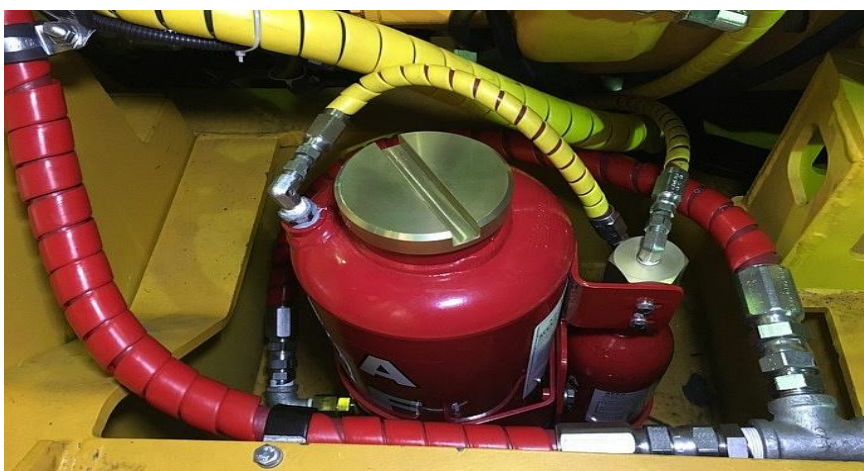
Рисунок – Система пожаротушения шахтного самосвала [2]
