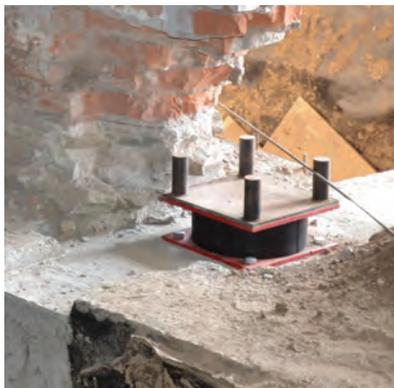
Рис 3. Смонтированная РМО
