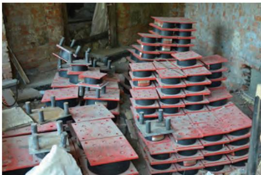
Рис 2. Резинометаллические опоры до монтажа
