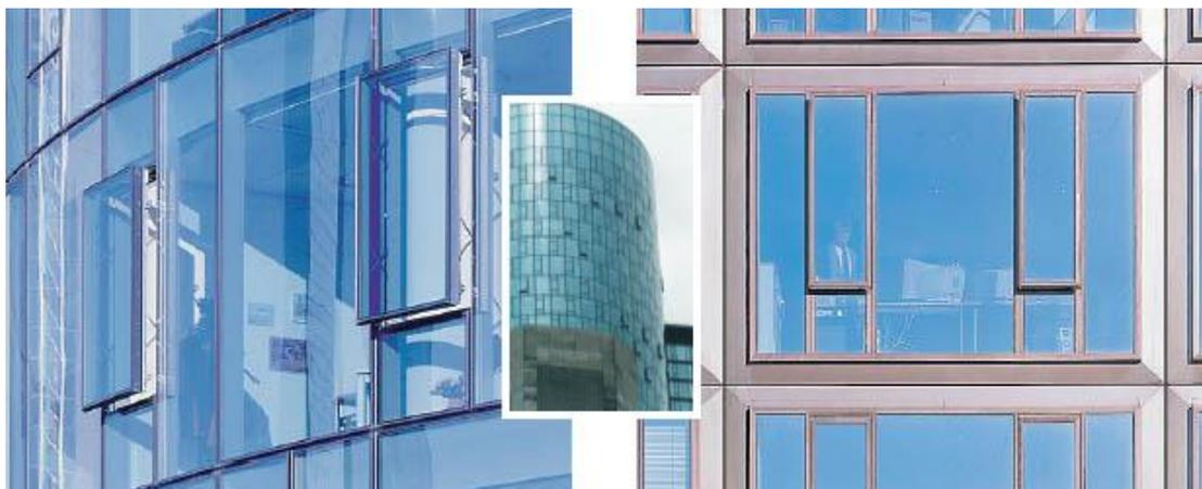
Рисунок 6 - Вариант наружных ограждающих конструкций здания «MAIN TOWER» - остекление стеклопакетами со створками, выдвигаемыми параллельно фасаду
