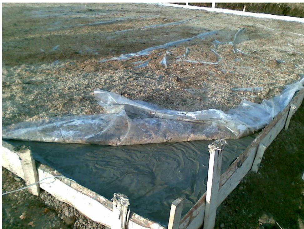
Рисунок 1 – Устройство и прогрев бетонной смеси на промышленных стройках
