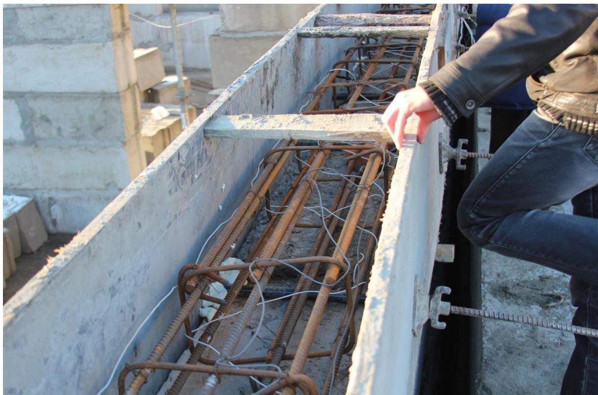
Рисунок 2 – Пример утепления опалубки пенопластом
