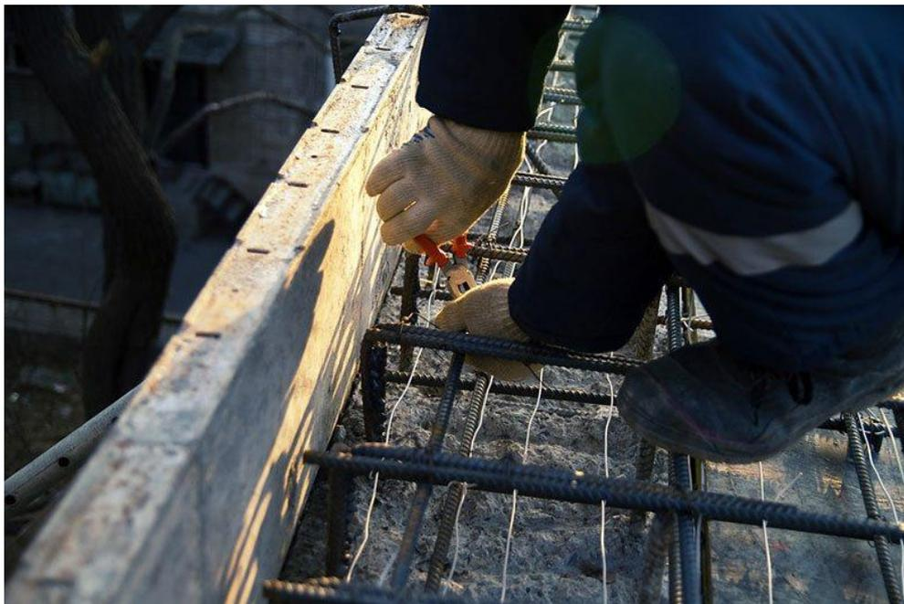
Рисунок 3 – Расположение нагревательными проводами в арматурном каркасе
