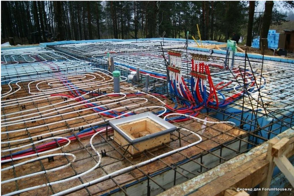
Рисунок 4 – Укладка греющего провода ПНСВ в арматурном каркасе
