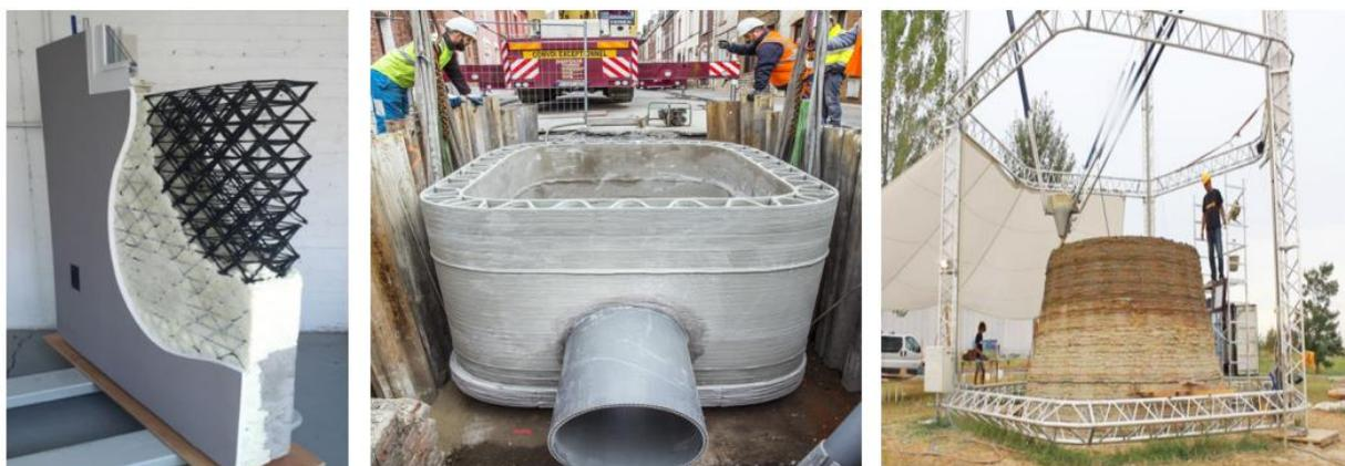
(а) C-Fab стенные перегородки (б) 3D бетонная ливневая канализация
