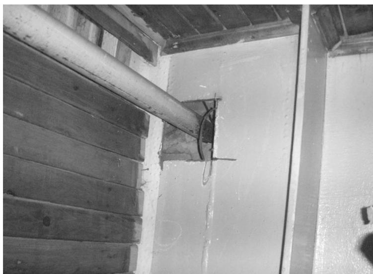
Рисунок 1 - Вырез в стойке рамы
