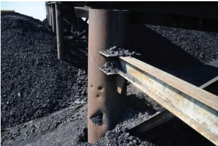
Рисунок 3. Следы механического воздействия на опору галереи
