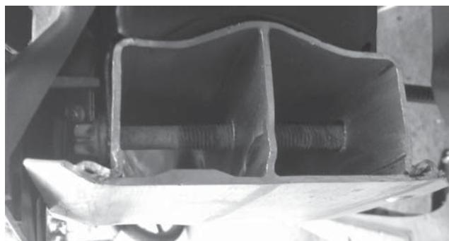
**Рис. 5.** Коррозия болтов с цинк-ламельным покрытием при соединении горячеоцинкованных деталей
